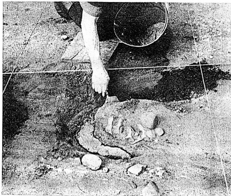
Foto 1 — Fase da cimentação: colocação da argamassa de cimento por baixo do bloco testemunho.
